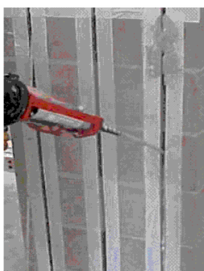
(a) Application of Embedding Paste بکار بردن و جاسازی نمودن چسب
