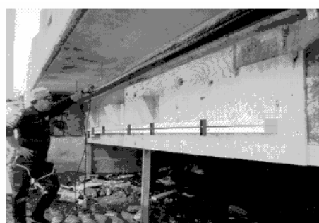
Forming concrete section شکل دادن به مقطع بتنی
