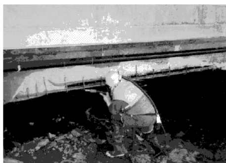
Sandblasting of corroded steel ماسه پاشی به فولاد خورده شده
