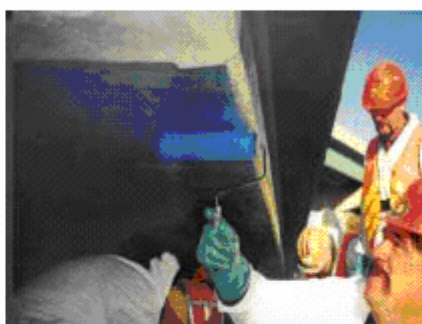
(d) Application of Saturant
