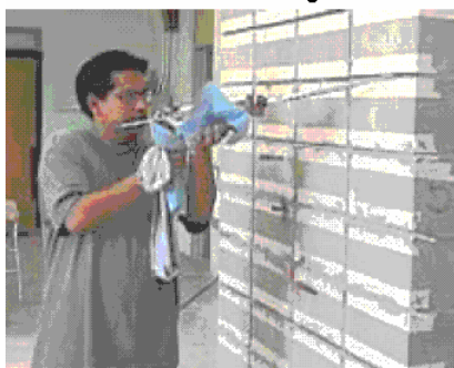
(a) Application of Embedding Paste بکار بردن و جاسازی چسب
