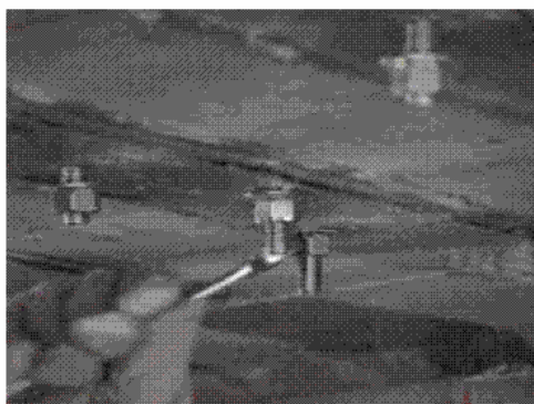
Tightening of anchors محکم کردن انکر یا مهارها
