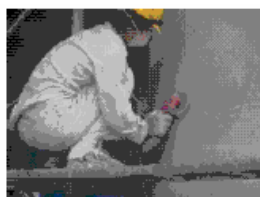
(a) Grind the surface ساییدن سطح
