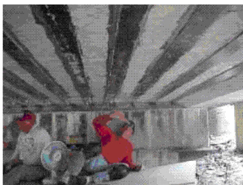
Driving anchors into slab فرو بردن انکرها در دال بتن آرمه
